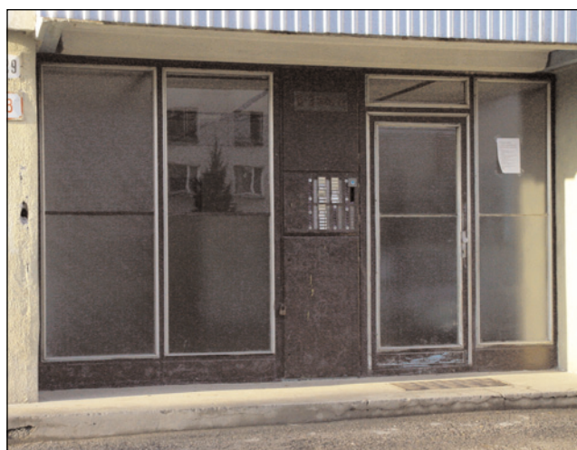
Vchod pred rekonštrukciou
